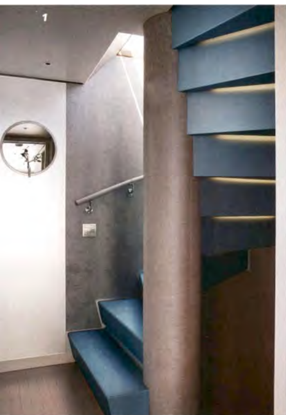
1 Лестница. Ступени сделаны из анодированного алюминия с патинированием. 2 Задняя палуба. Диван, кресло и столики, Paola Lenti; на полу палубная доска из массива тика.
